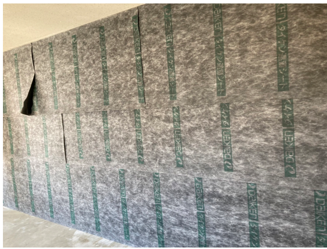
↑ 間仕切りの間に遮音シートを挟みました。
