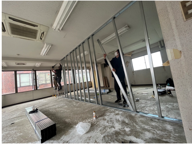
↑ ちよくちよく早川も内装工事に参加しています。
