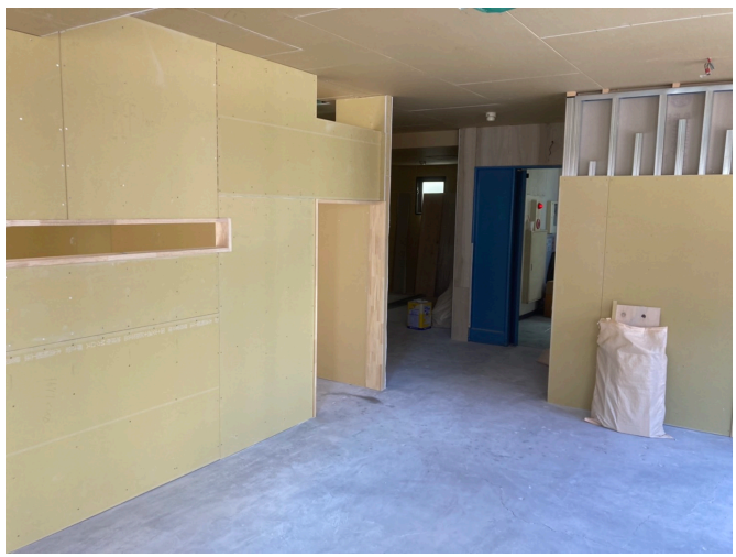
↑ 2階は間仕切りまでが終了している状況です。
